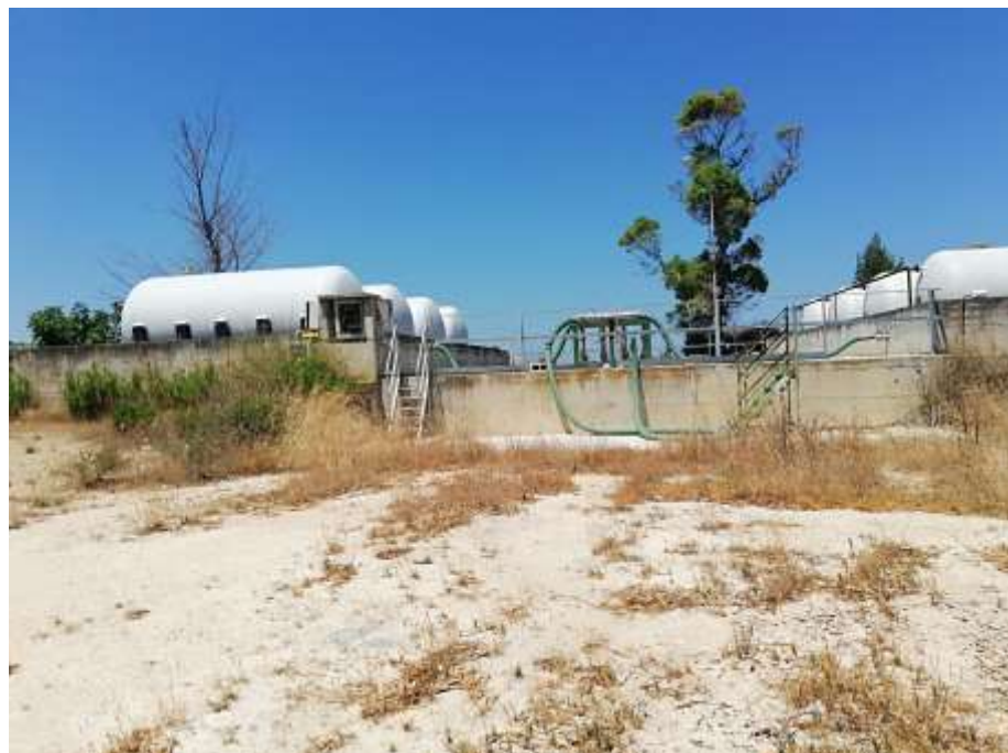
Punto di carico Percolato
