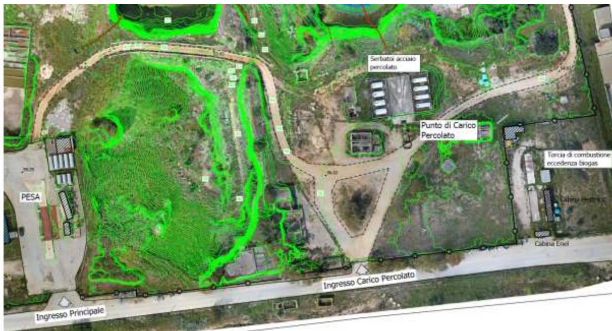
Ingresso Principale – Punto di carico Percolato
